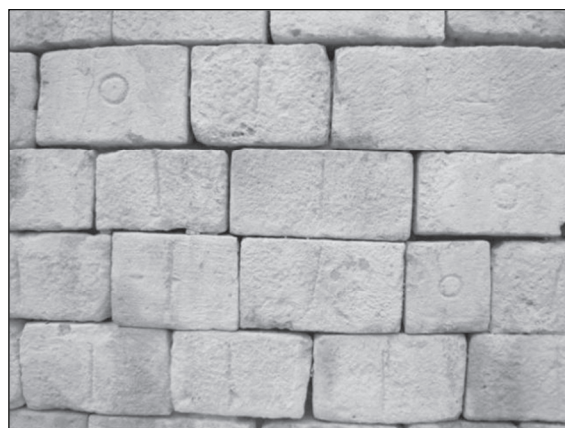
تصویر ۱۲- علائم حجار بر سنگ‌های پل شماره یک پاتاوه (مأخذ: نگارنده)
