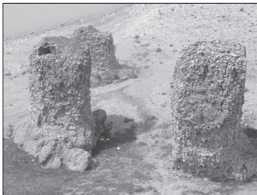
تصویر ۹- پل چم چیت کهگیلویه، دید از جنوب غرب (مأخذ: نگارنده)
