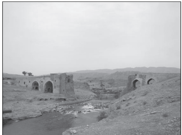
تصویر ۴- پل شماره سه خیرآباد (مأخذ: نگارنده)
